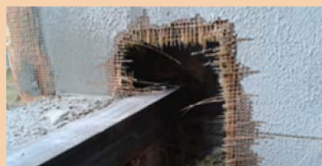
Рисунок 4. Проникновение структурного элемента сквозь изоляцию
