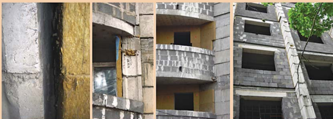
Рисунок 2. Установка изоляции на стену
