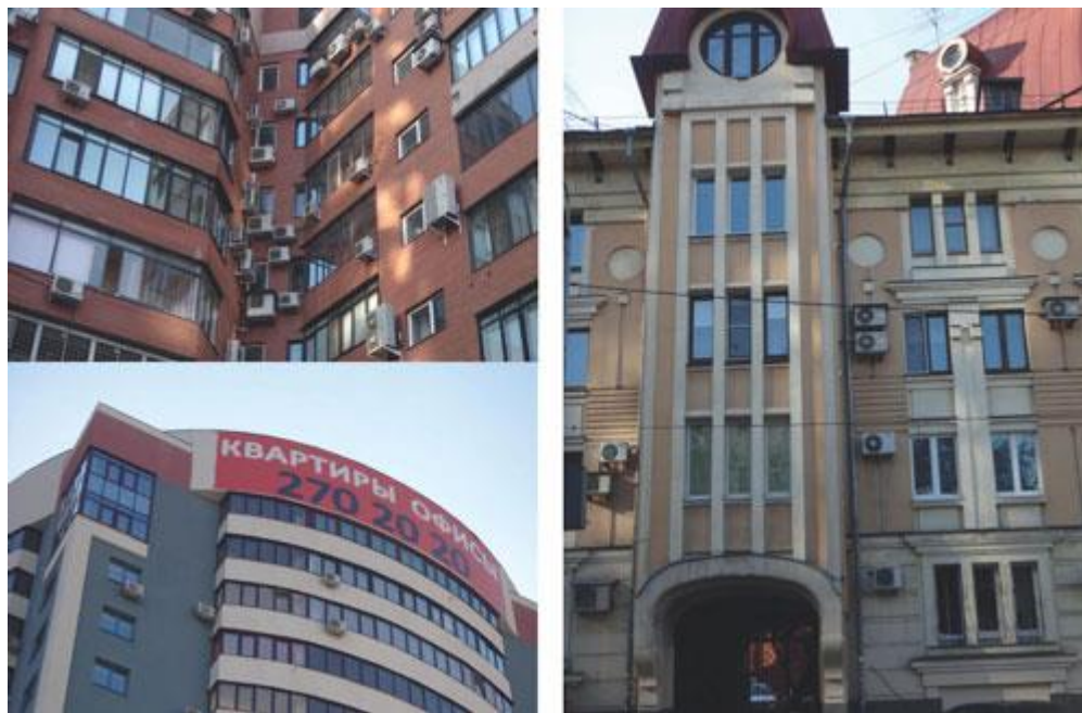
Рисунок 2. Фрагменты фасадов элитных жилых комплексов в Самаре
