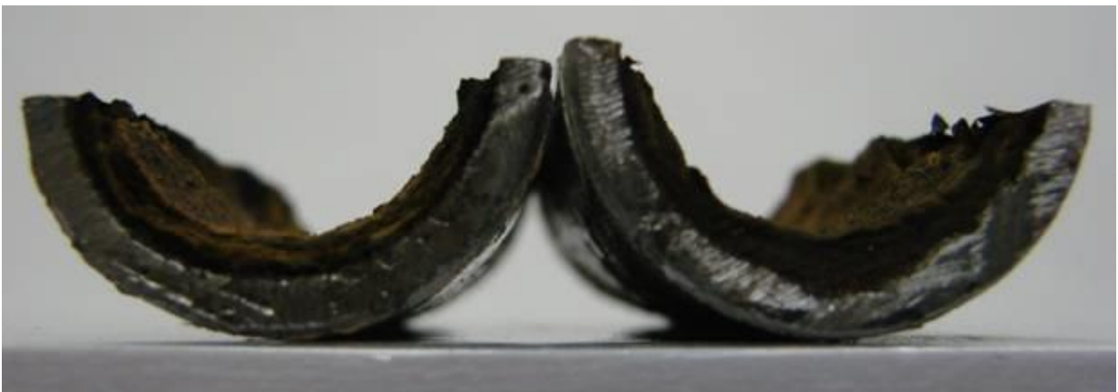
Рис. 2. Исходная поверхность участка трубопровода системы отопления.
