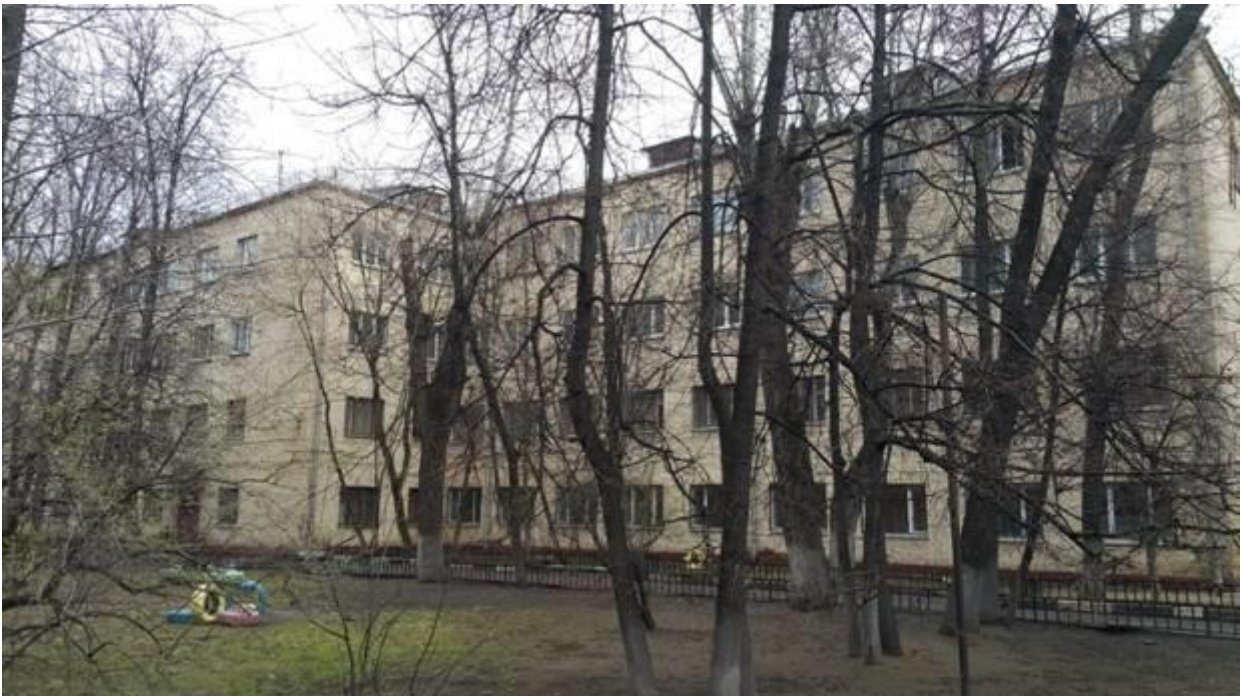
Рис. 1. Здание Санатория-профилактория НИУ «МЭИ».
